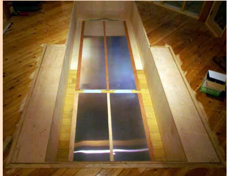
ヒーター敷設写真
